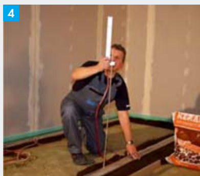
Если поверхность требуется выровнять по высоте (произвести нивелирование), для этого следует использовать специально предусмотренный для этого комплект инструментов.
