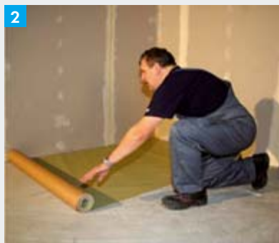
На перекрытии из деревянных балок уложить паропроницаемую подкладочную бумагу.
